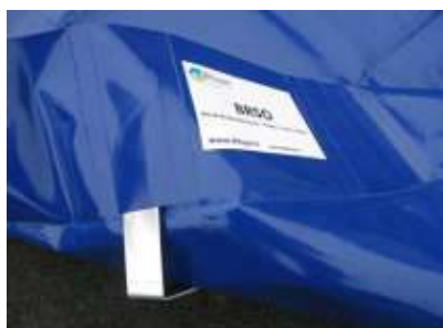
Insertion équerre dans un fourreau
